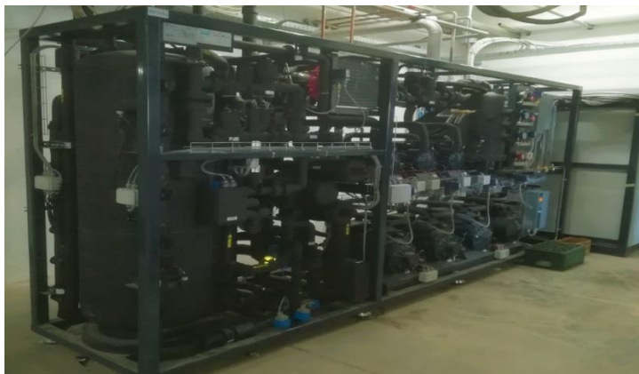
Figura 1. Unità transcritica a CO 2 nel supermercato a Pyrgos, Greece
