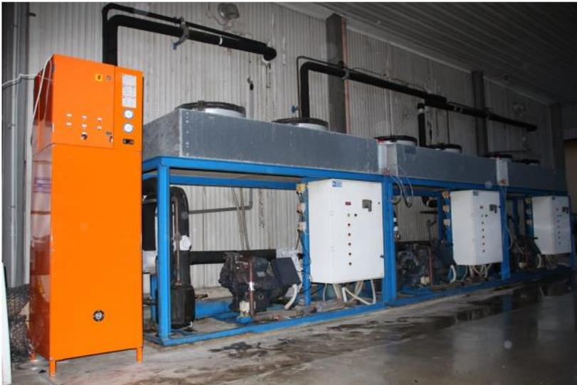
Figura 4: Impianto pilota – Resa frigorifera 30kW
